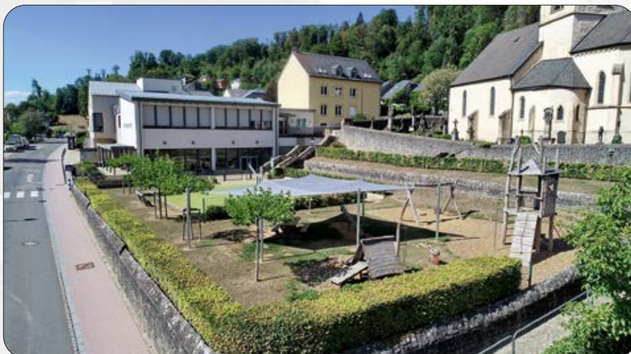
Das Schulgebäude in Simmern.
